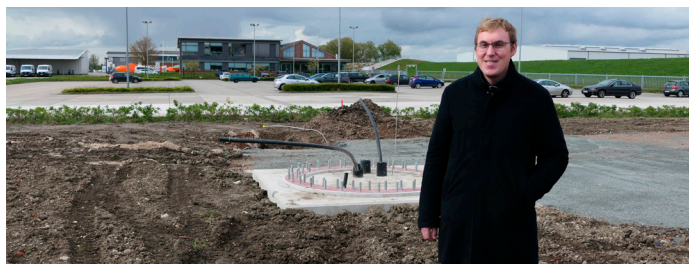
Bei Redaktionsschluss kann Fertigungsleiter Markus Hatecke nur das Fundament der ersten Windkraftanlage präsentieren. Wenn der Blick ● erscheint, soll die erste Anlage jedoch stehen.
